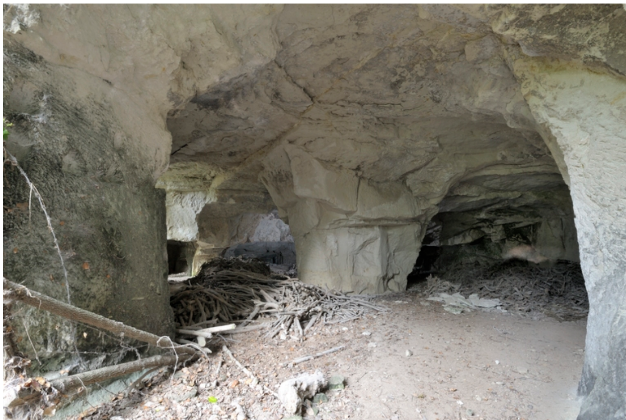
Champfleury : carrière de tuffeau avec extraction par pilier tourné (en partie sous la commune de Turquant).
