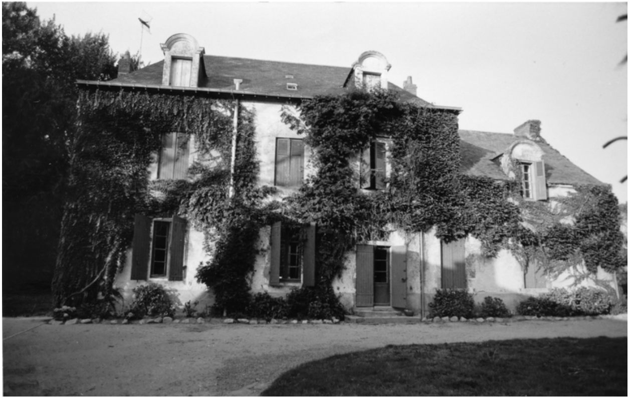
Vue d'ensemble du logis depuis le sud-ouest. 1990.
