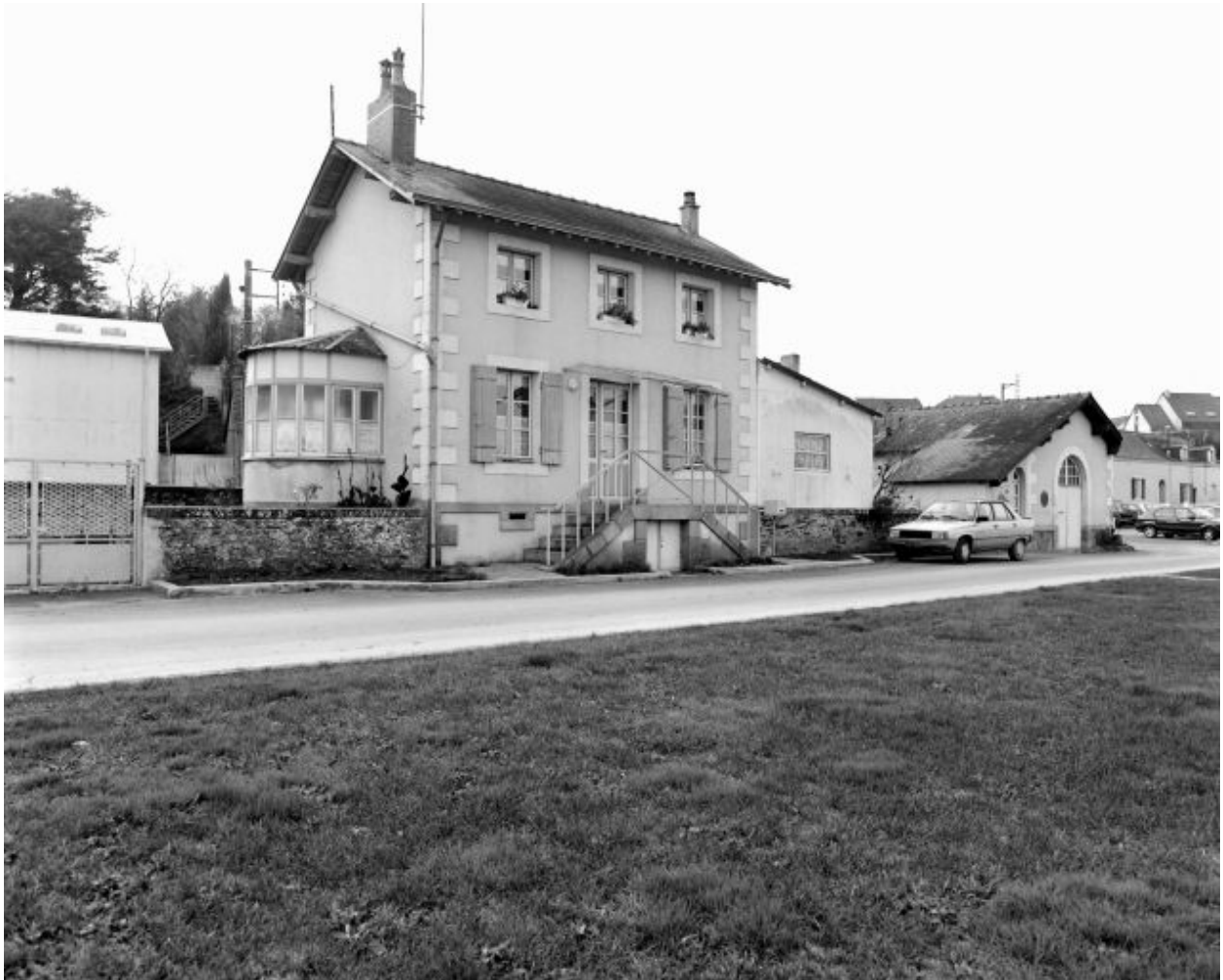
La maison éclusière.
