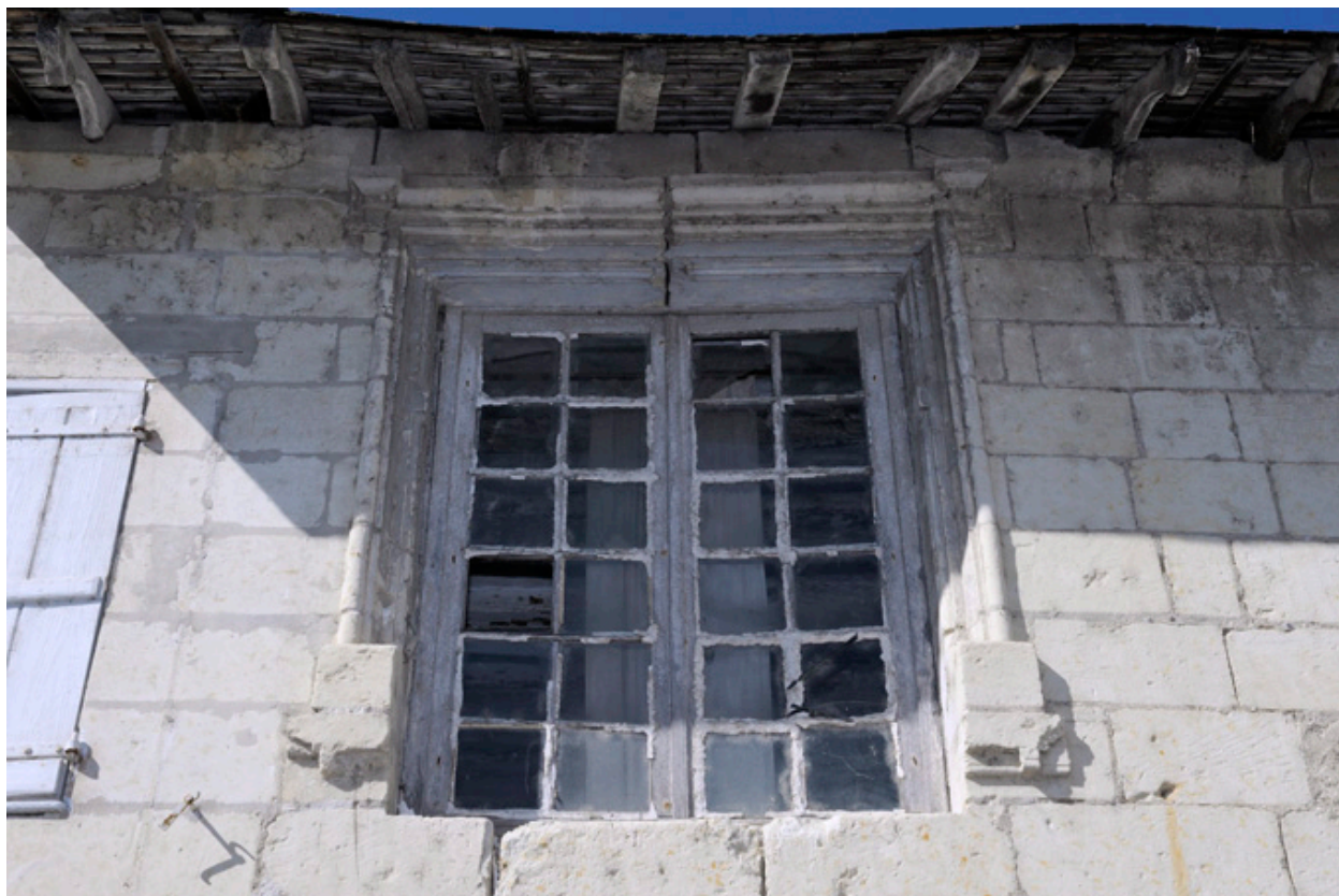
Façade est. Baie, de l'étage, première moitié du XVI e siècle (remaniée au XVIII e siècle).
