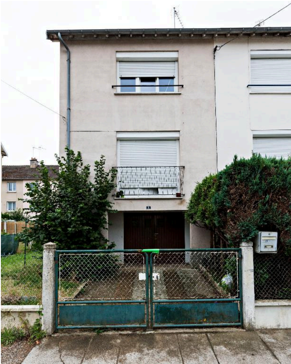
Elévation antérieure de la maison 3, rue du docteur Roux.
