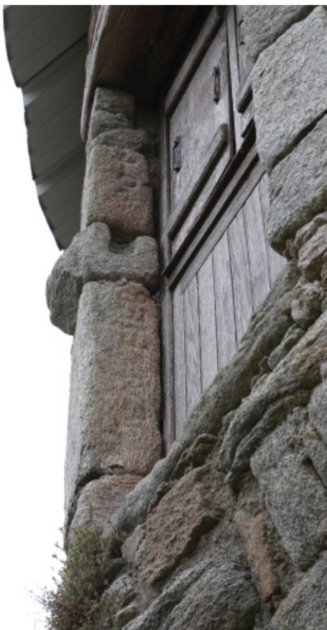
Cage, porte haute ouest ; détail du montant gauche.
