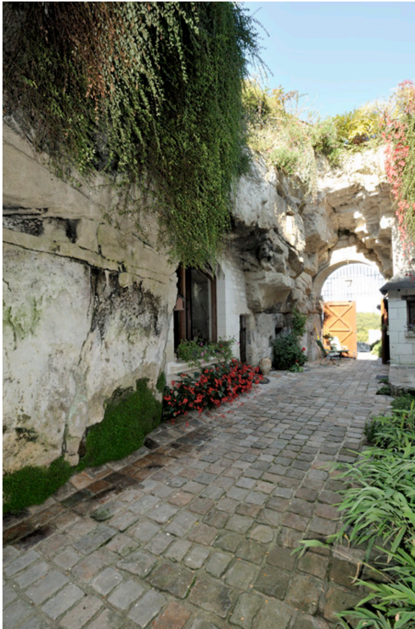
4, chemin des Perreyeurs. Entrée de la galerie d'extraction et premier fontis.
