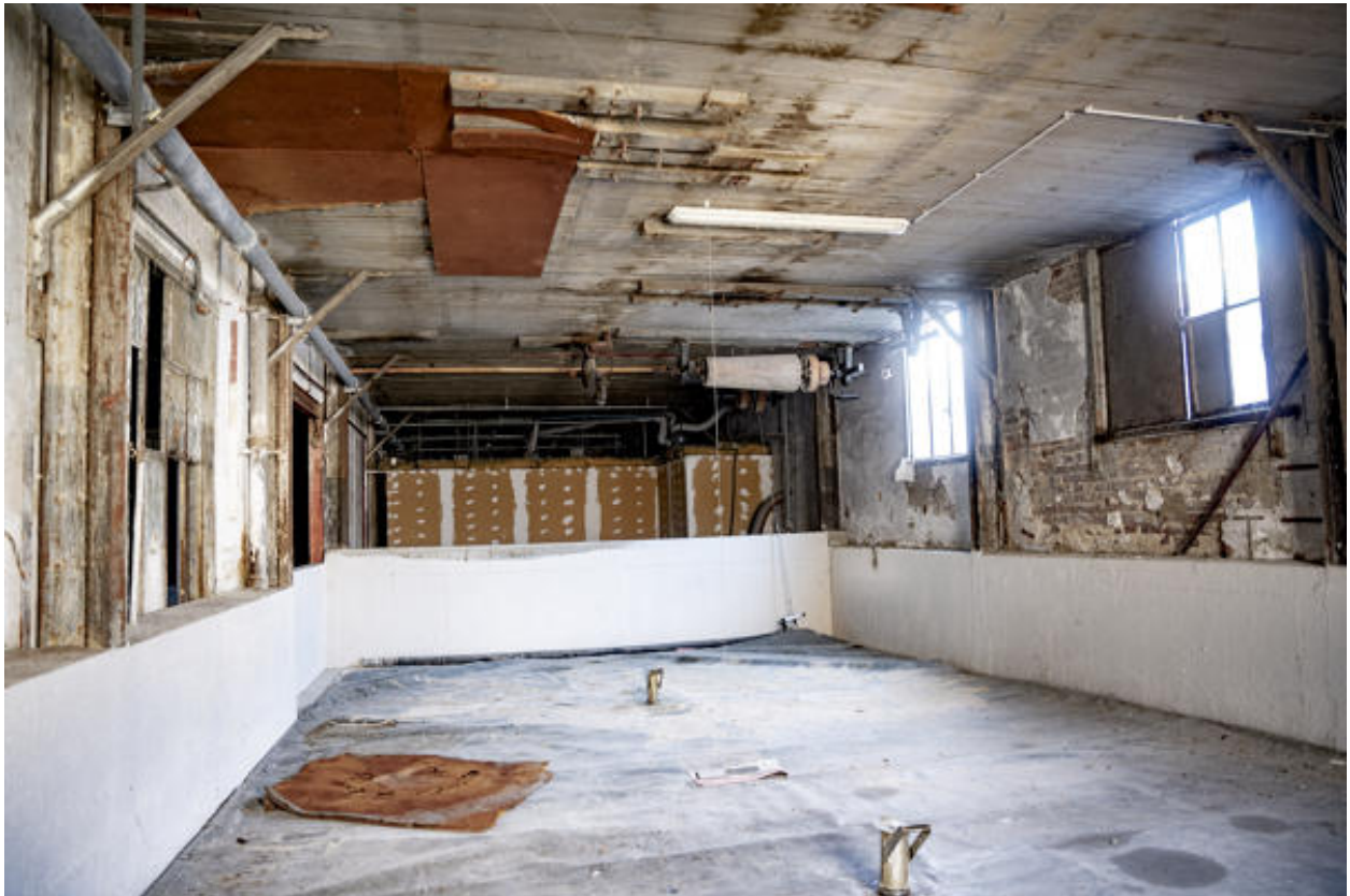
Vue intérieure de l'un des étages du bâtiment D.
