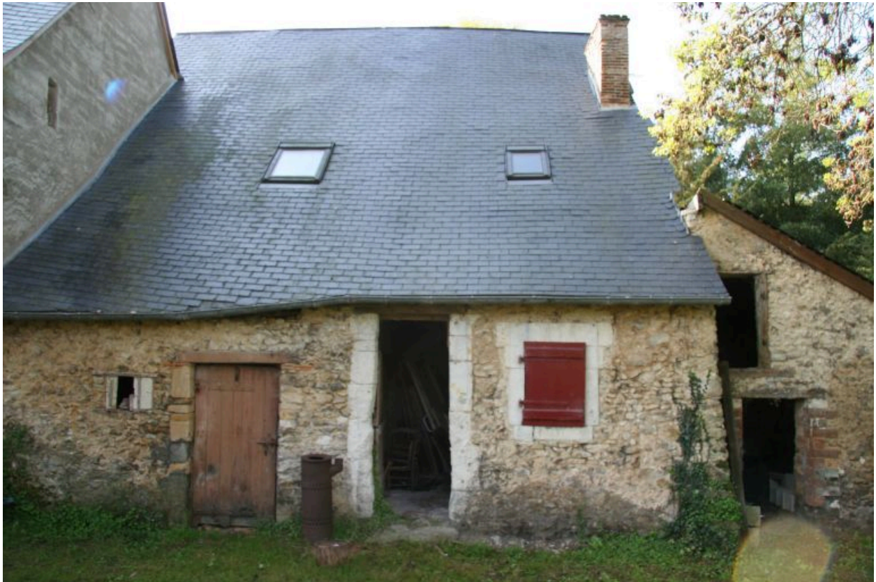
L'ancienne maison du meunier : façade côté route.
