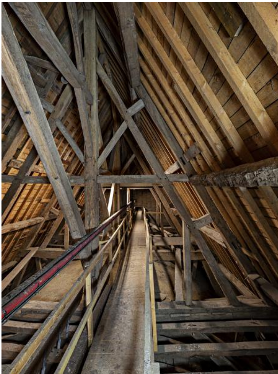
Comble de la chapelle du couvent des Ursulines de Château-Gontier. Vue dans sa longueur de la charpente couvrant la nef.
