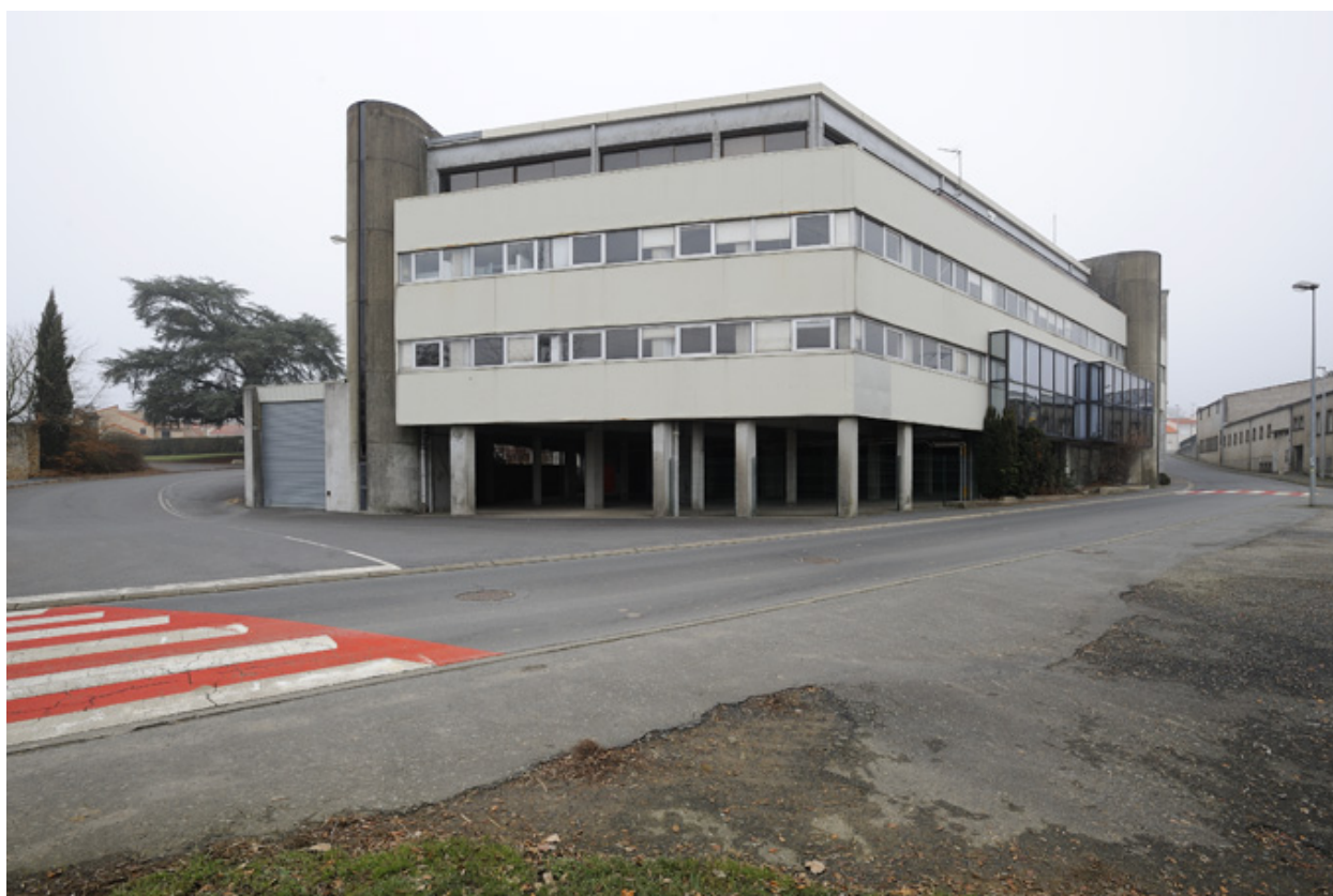
Bureaux de l'entreprise Gep (U1) construit en 1968.
