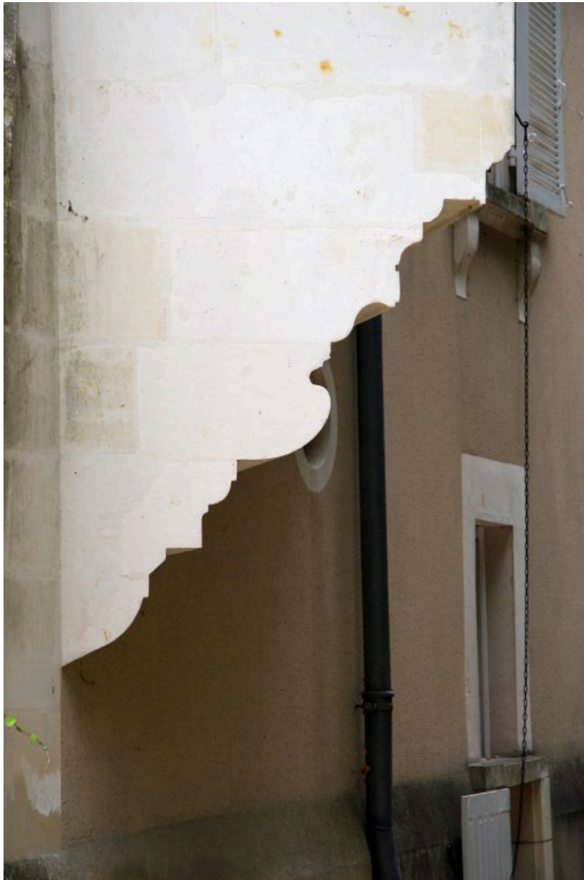
Tour de l'éperon, détail : profil des moulures de l'échauguette.
