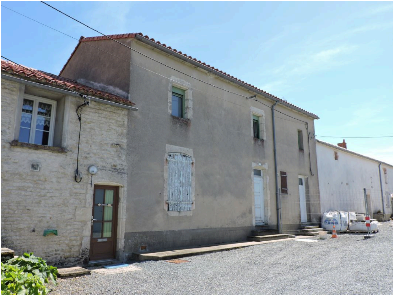
La maison du numéro 5, surélevée en 1960, vue depuis le nord.
