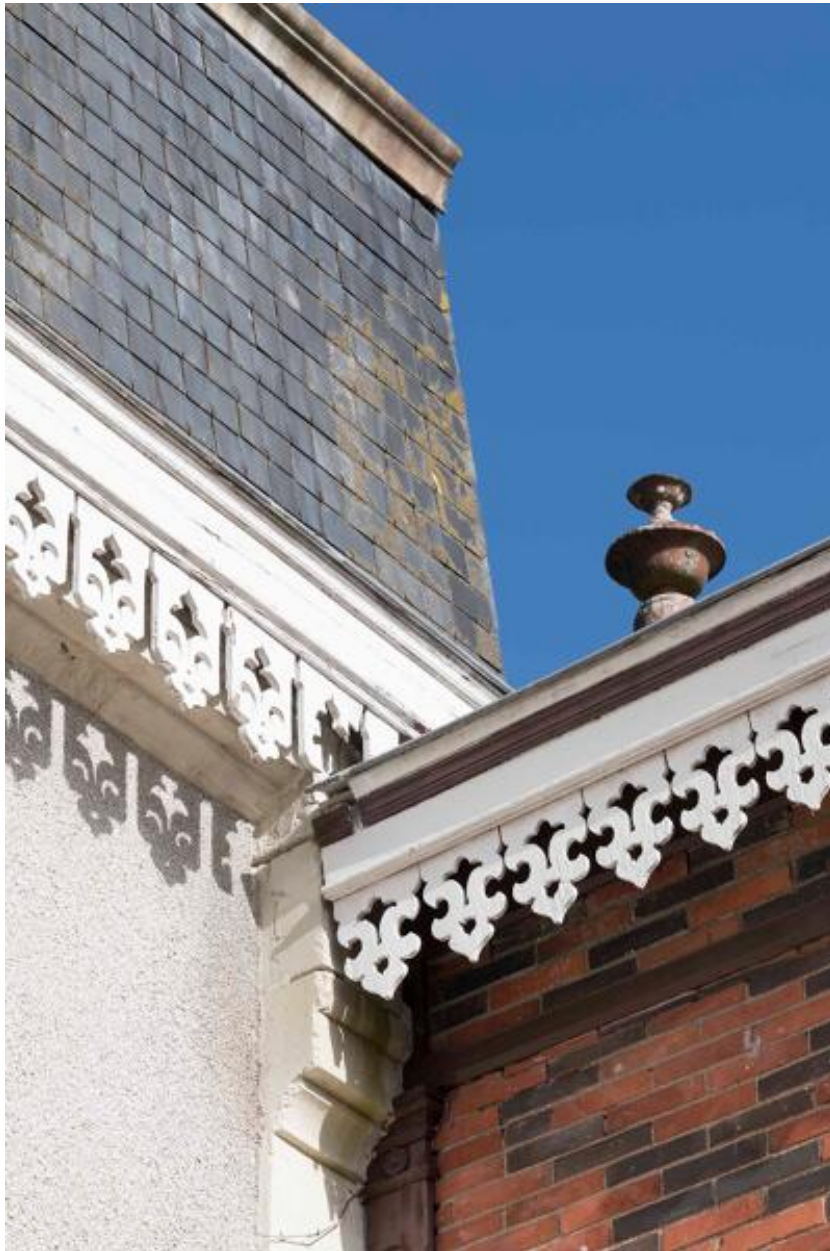
Façade est. Détails des lambrequins.
