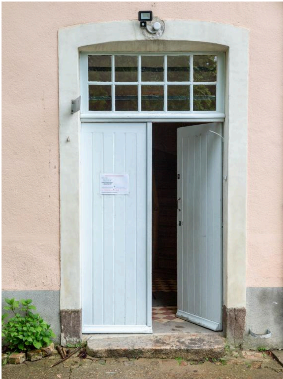
Porte d'entrée du corps central.
