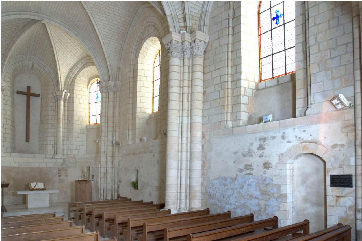
Chapelle Saint-Eloi. Nef, élévation intérieure sud.
