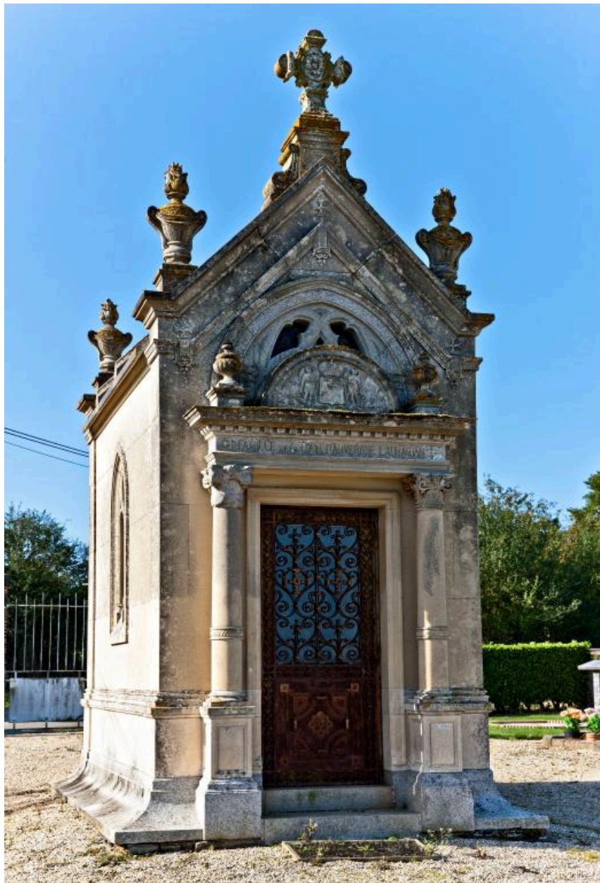
Vue d'ensemble de la chapelle depuis le nord.
