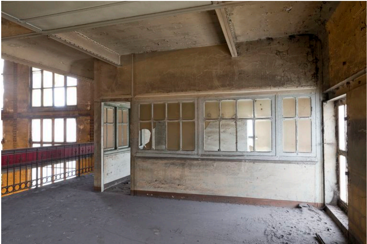
Bureaux, 2ème étage du bas côté nord.
