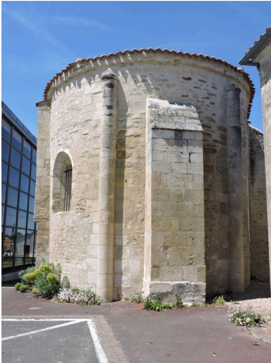
L'abside vue depuis l'est.
