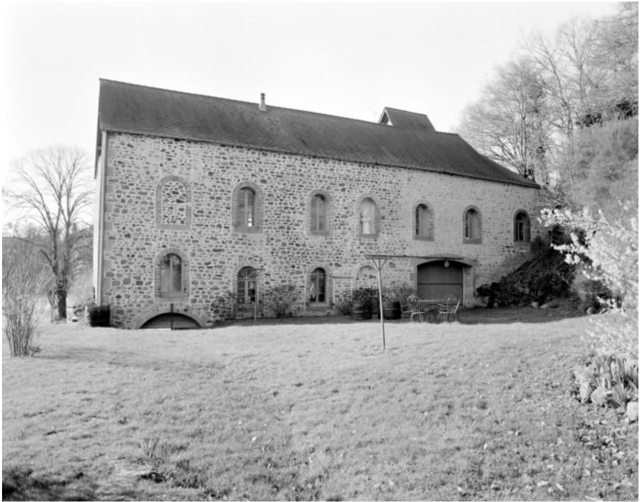
La façade nord (amont) du moulin.
