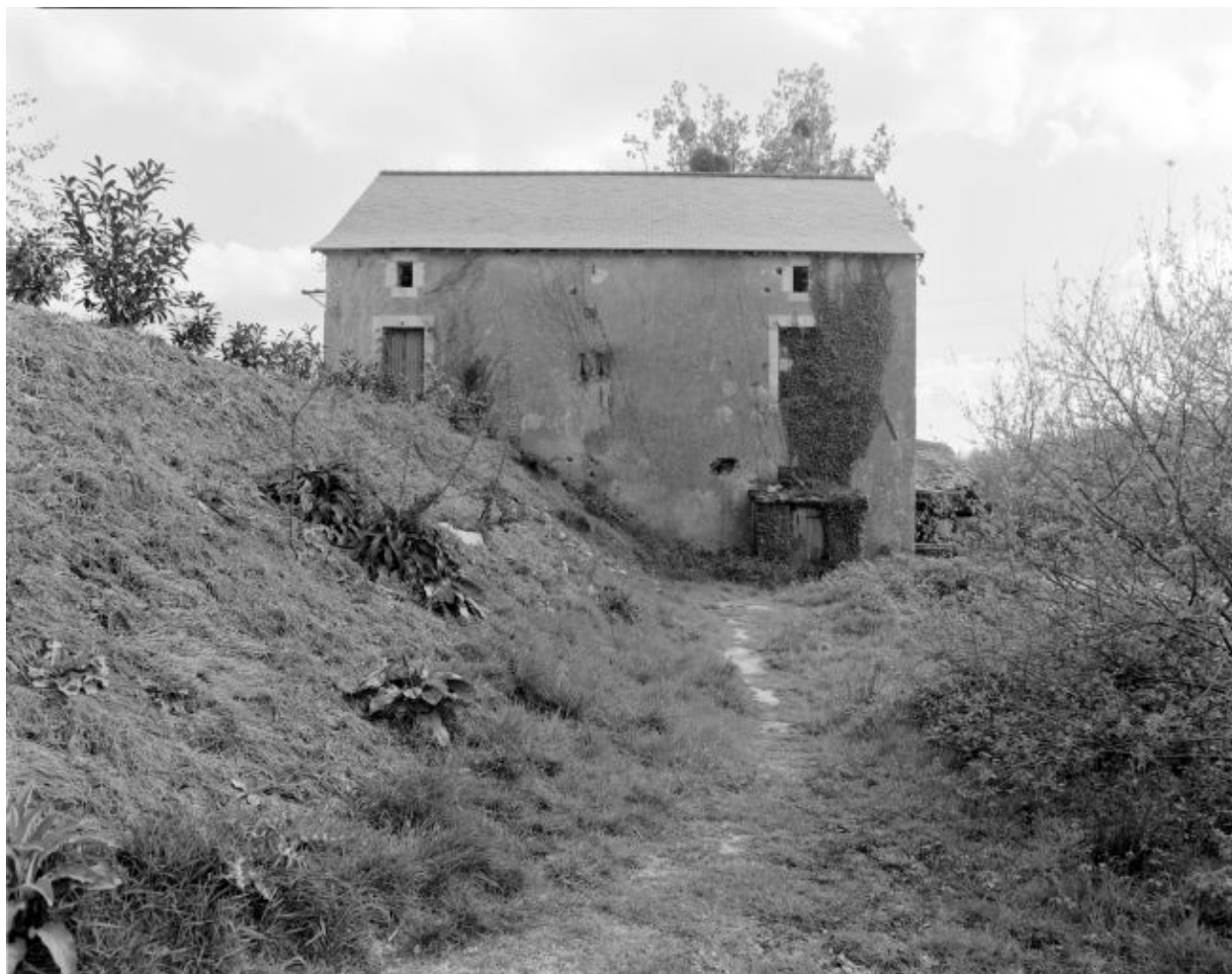
La façade nord (amont) du moulin.
