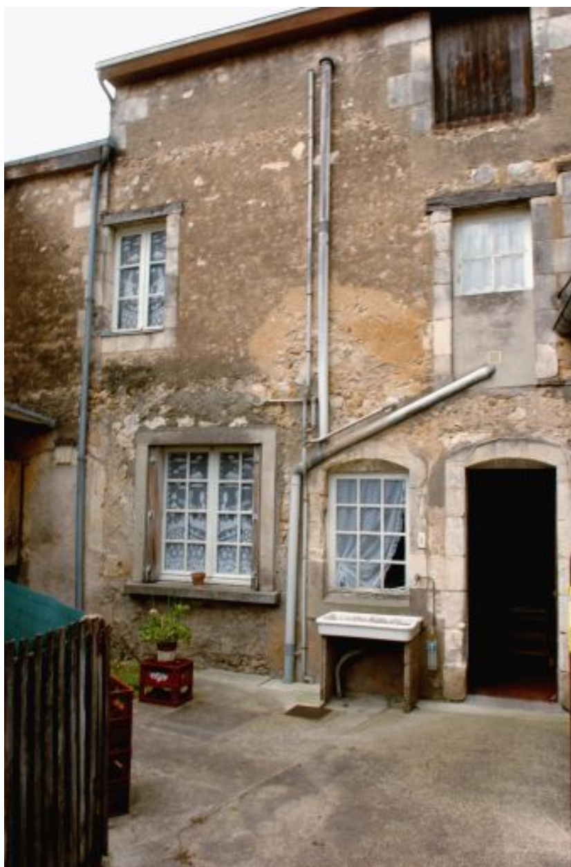
2 place de l'Église : façade postérieure.
