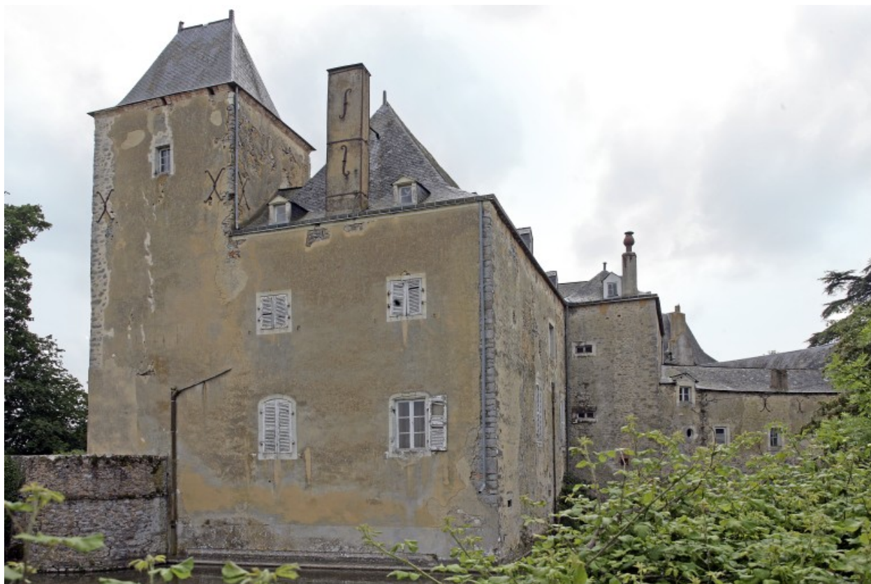
Le logis vu depuis le nord-est : la tour d'escalier, le corps principal et le corps postérieur.
