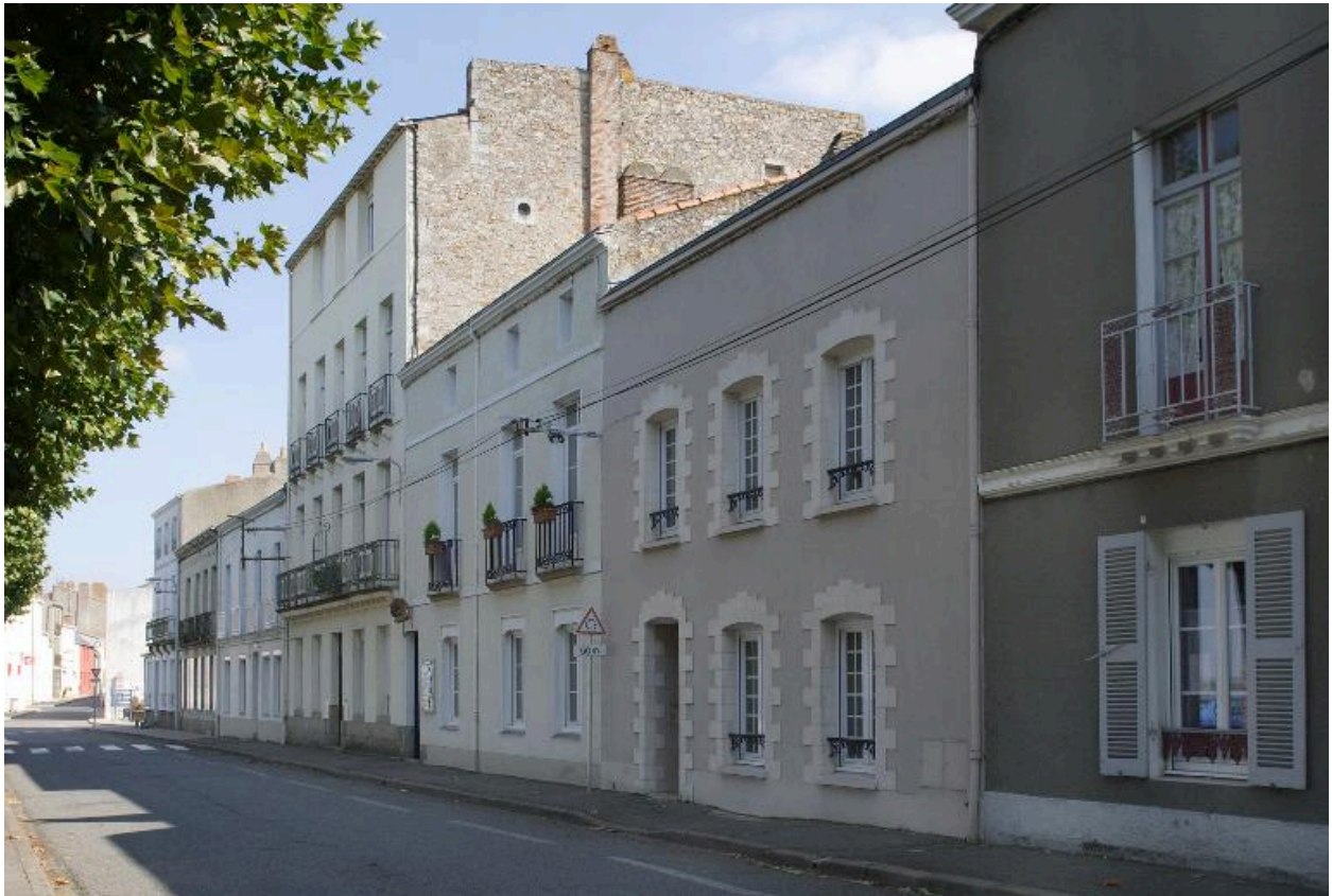
La façade sur le quai.
