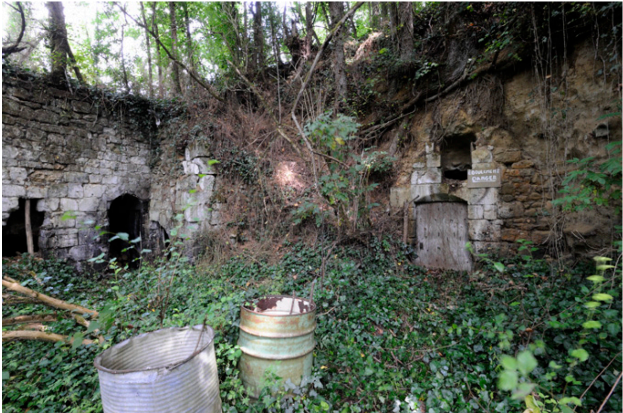
Angle nord-ouest de la cour : caves du XIXe siècle (à gauche) et du XVIIIe siècle (à droite).
