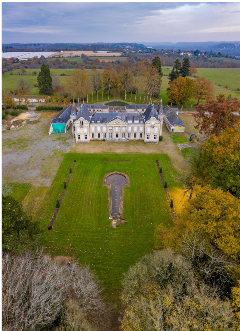
Vue aérienne depuis l'ouest.
