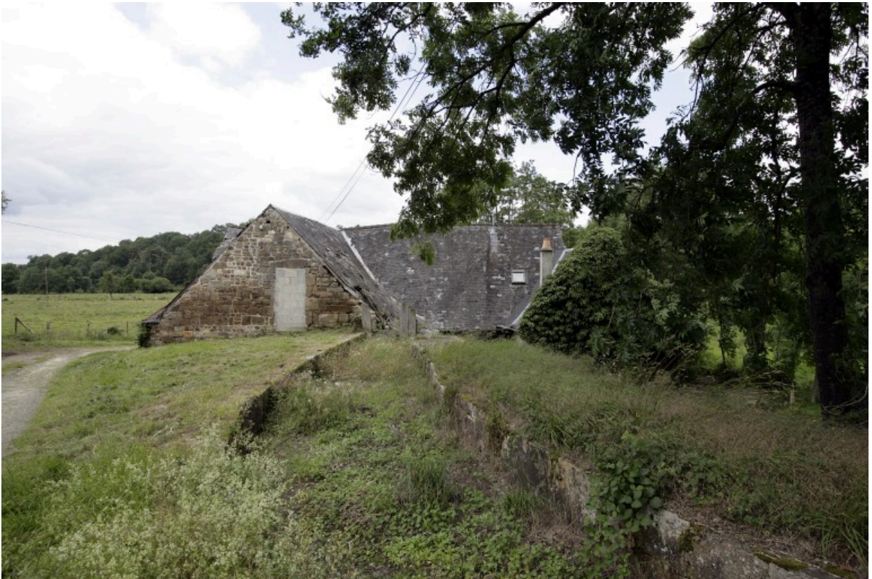
Le moulin vu depuis l'est. Au premier plan, le canal d'alimentation.
