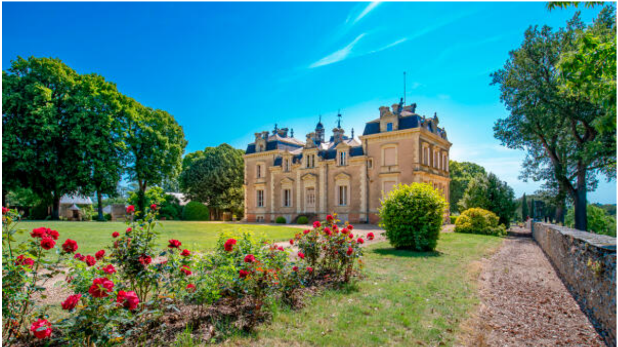
L'élévation postérieure, côté nord-ouest.
