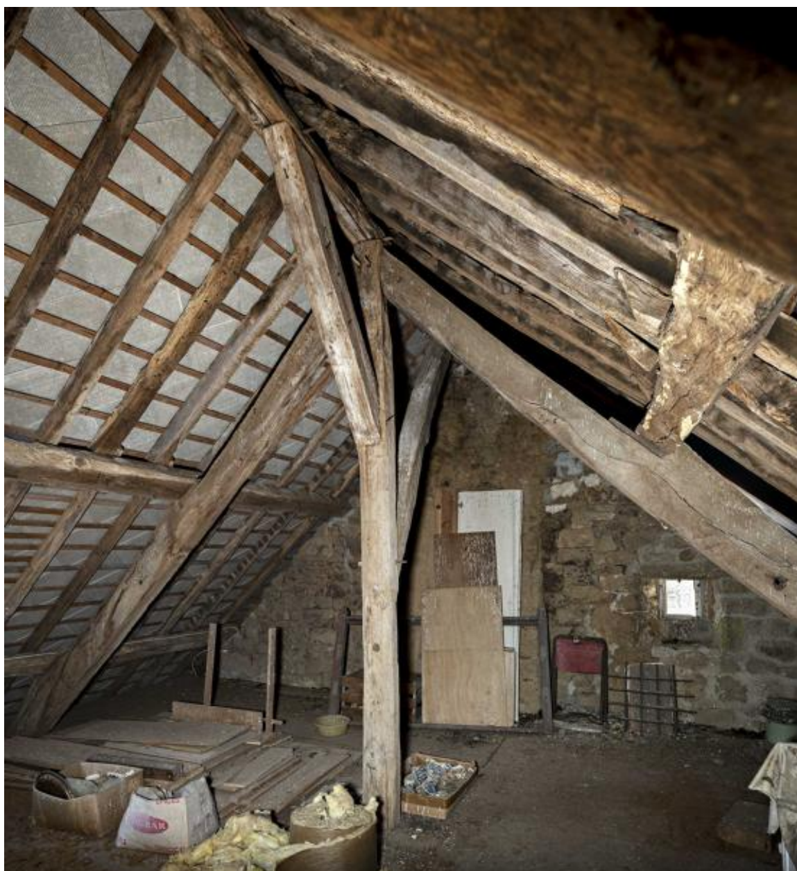
Logis sud, charpente.
