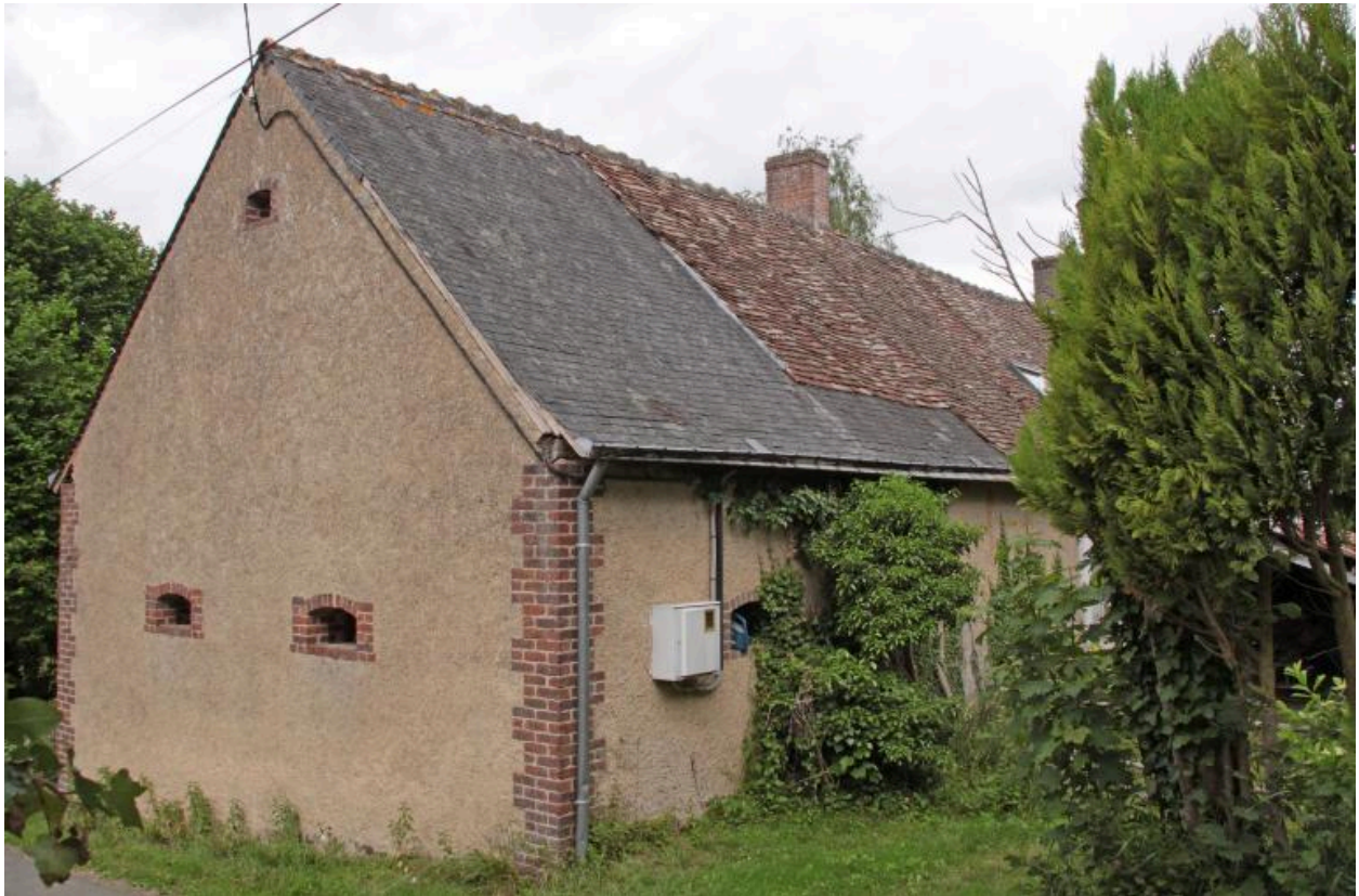
Vue de volume : mur-pignon et façade postérieure de l'étable.
