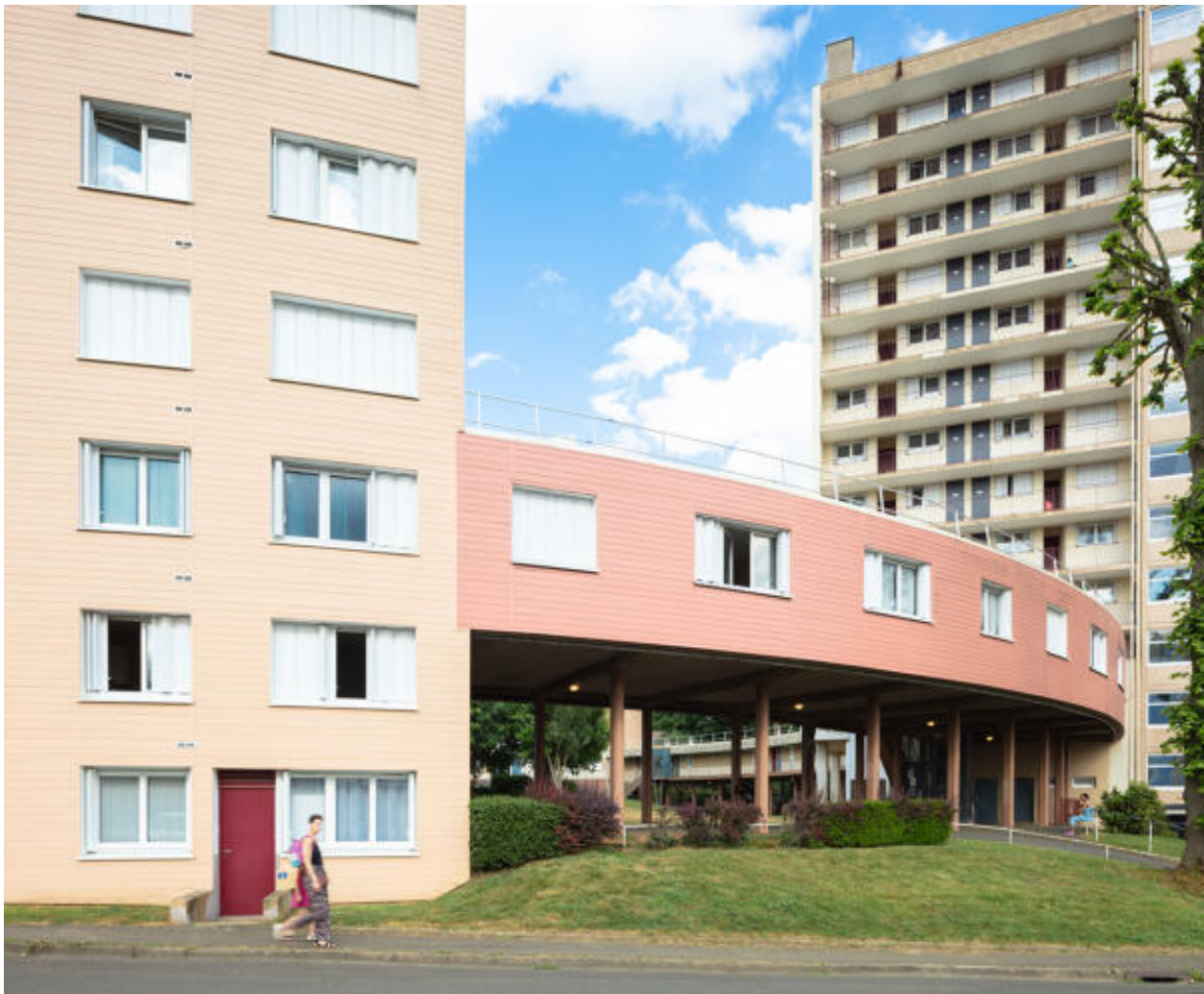
Vue de l'immeuble et du porche permettant d'accéder au bassin central depuis le sud.
