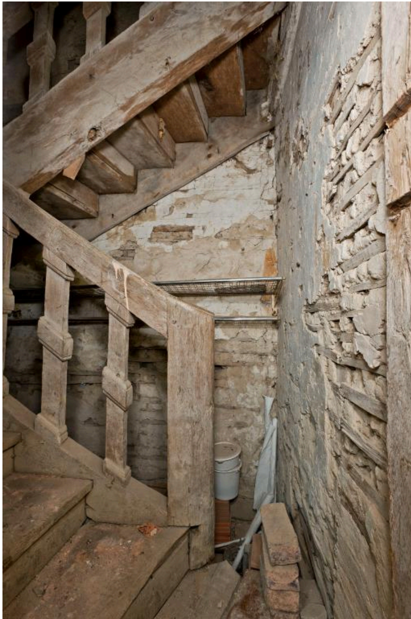
Cage d'escalier menant au comble.
