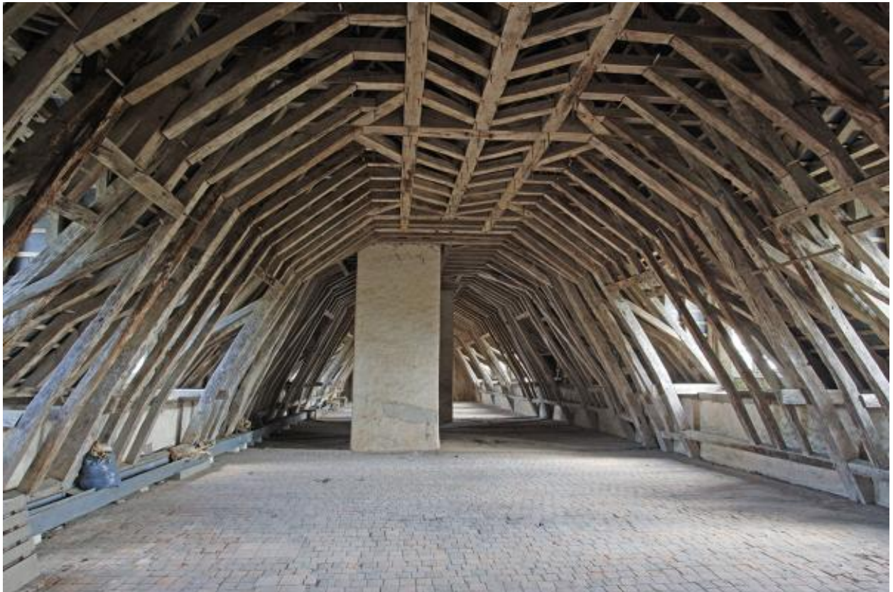
Le grand comble et sa charpente.
