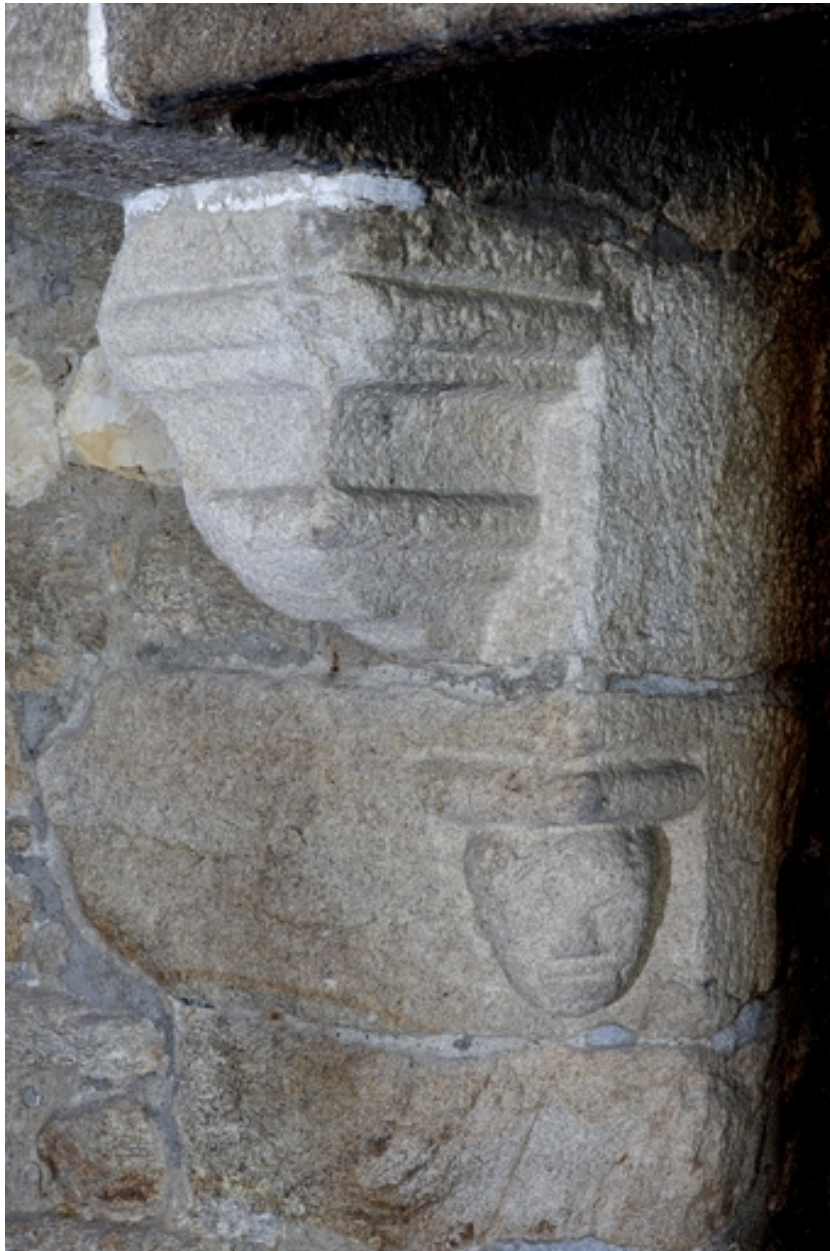
Maison n° 8 rue du Four. Rez-de-chaussée. Détail de la console de gauche de la cheminée.
