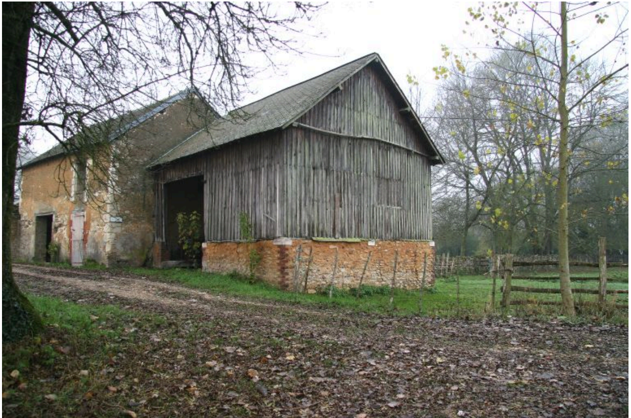
La grange et le hangar.
