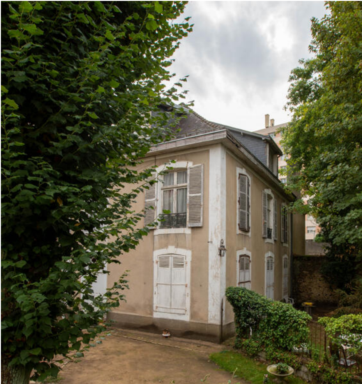
Vue de la façade latérale de la maison entre la rue Louis-Crétois et l'avenue Jean-Jaurès.
