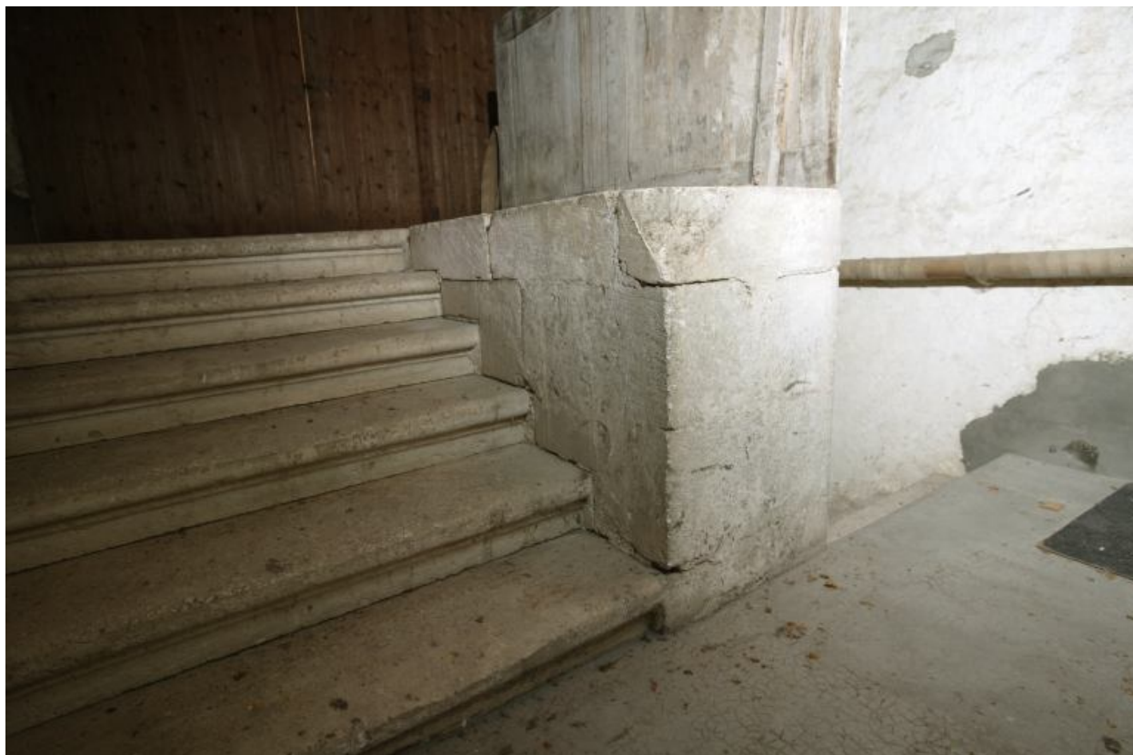
Partie supérieure de l'escalier du bâtiment nord.
