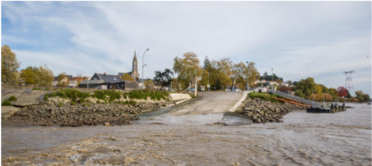
Vue générale de l'embarcadère du bac de Basse-Indre.
