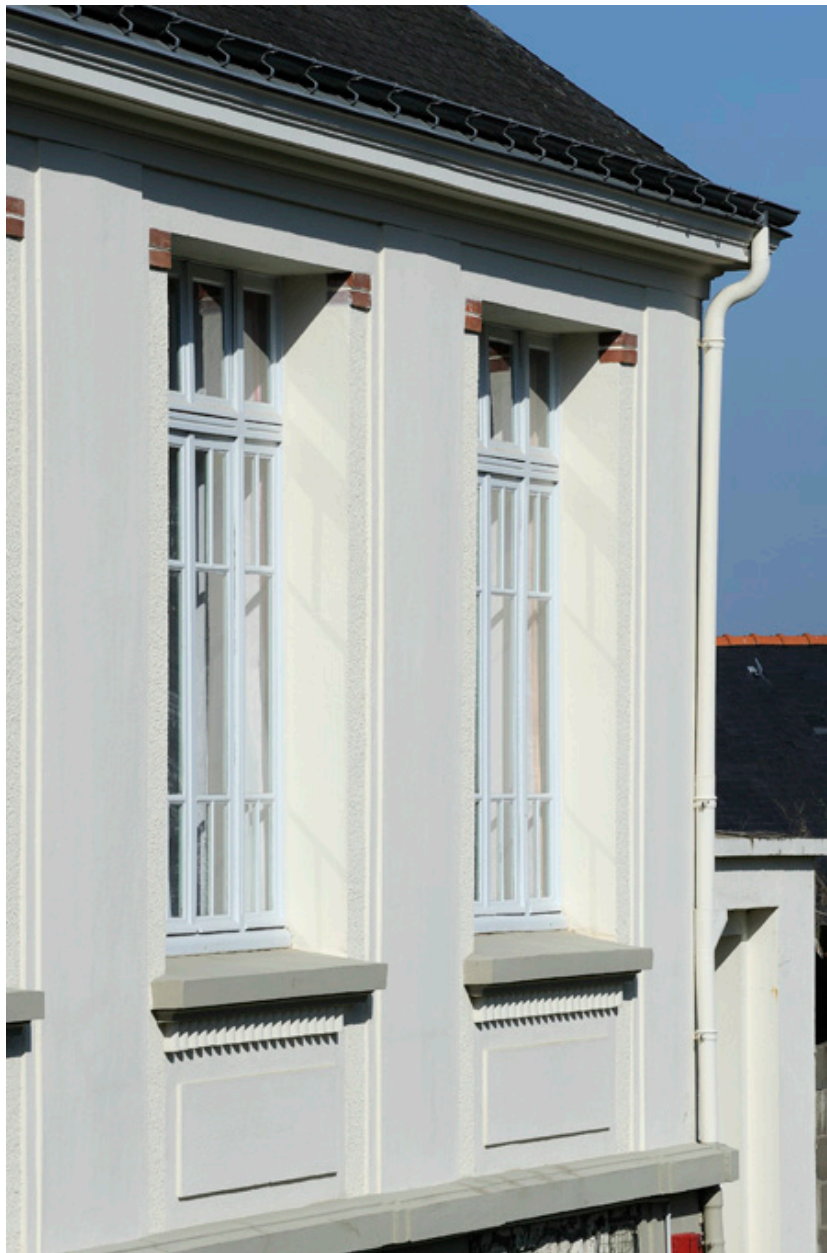
École : façade est, détail de deux baies (2)
