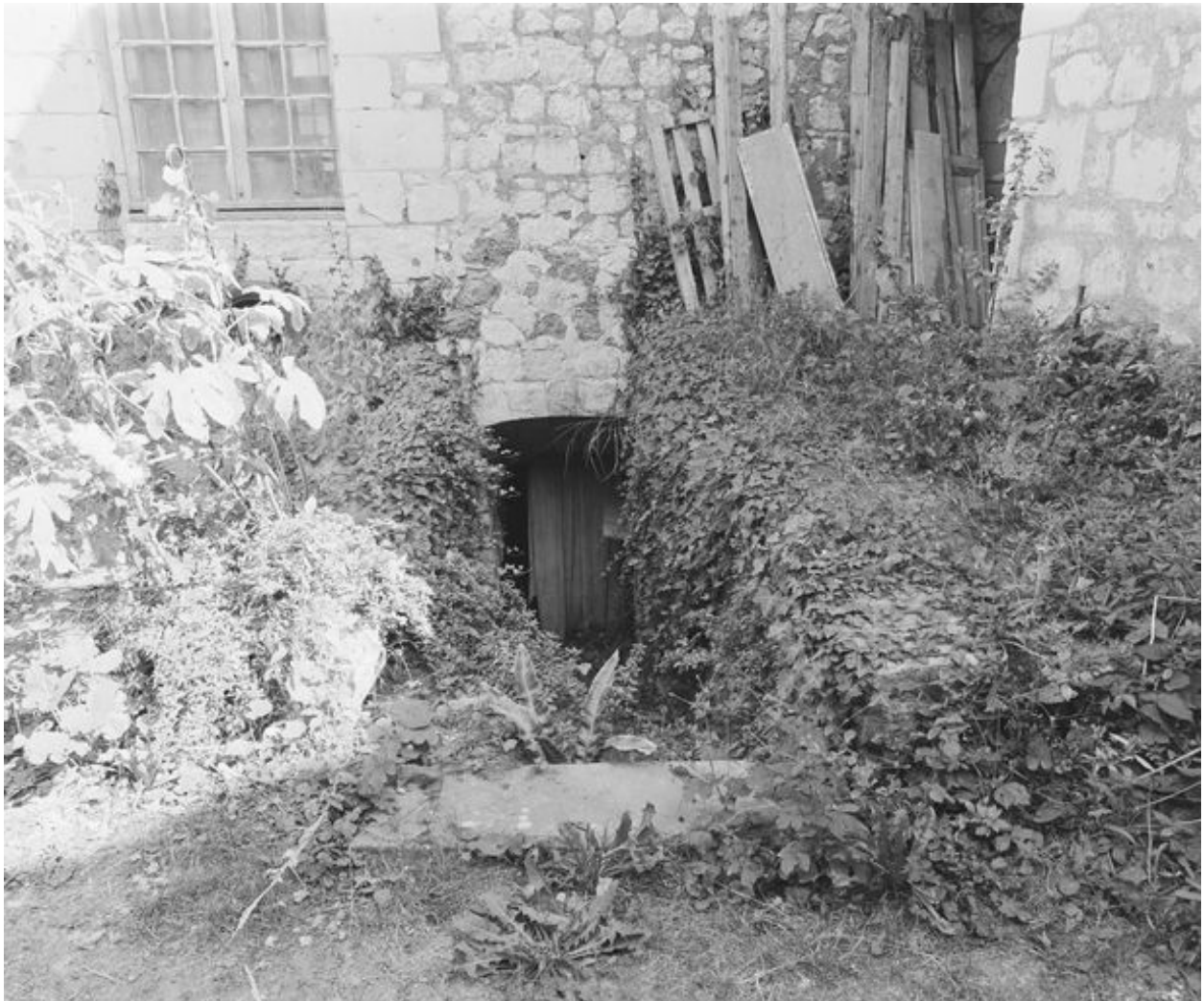
Accès à la cave, en façade orientale, sur cour (en 1996).
