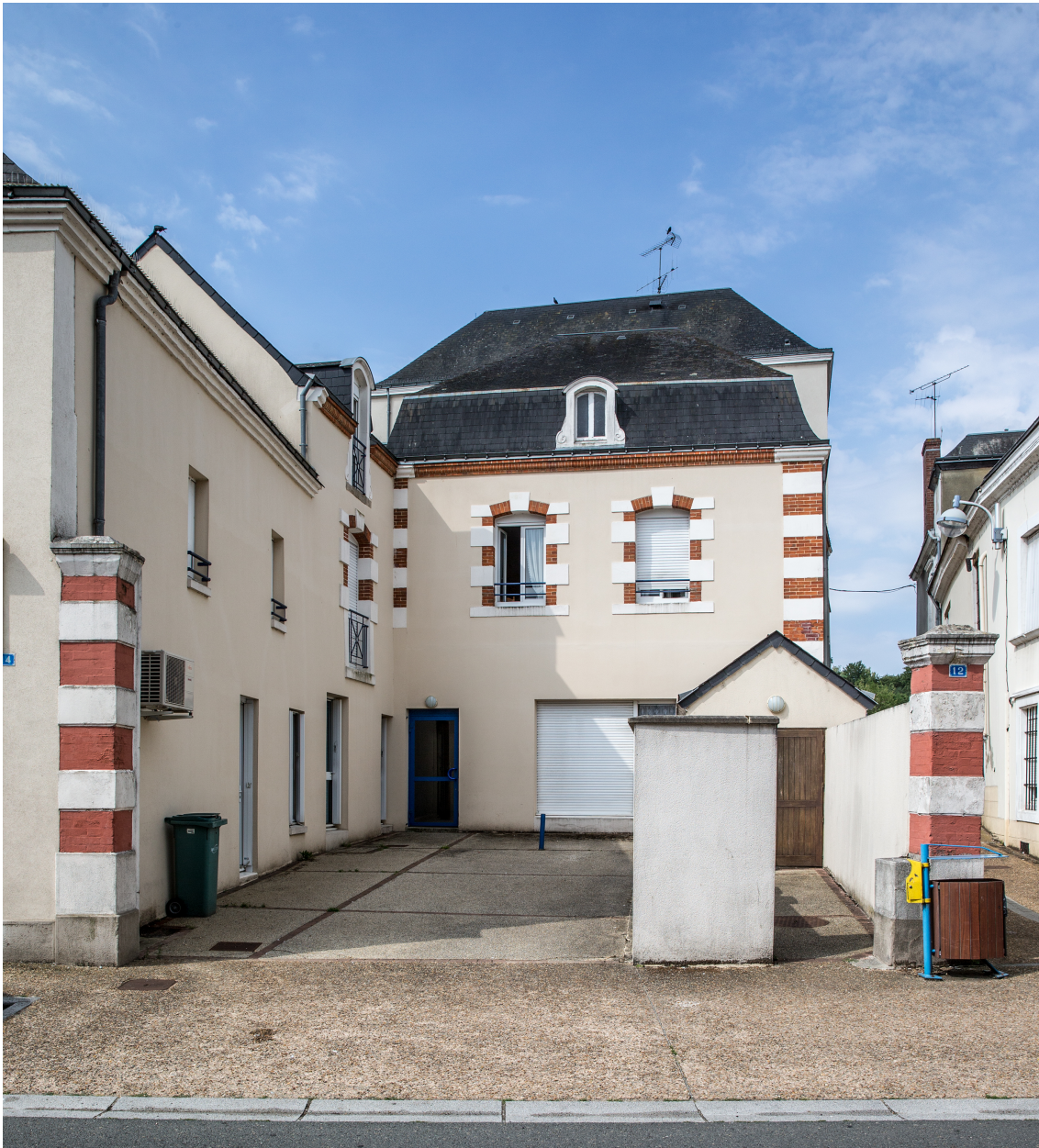
Les anciens bâtiments de l'usine.
