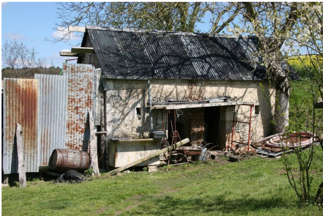
Vestiges des écuries.
