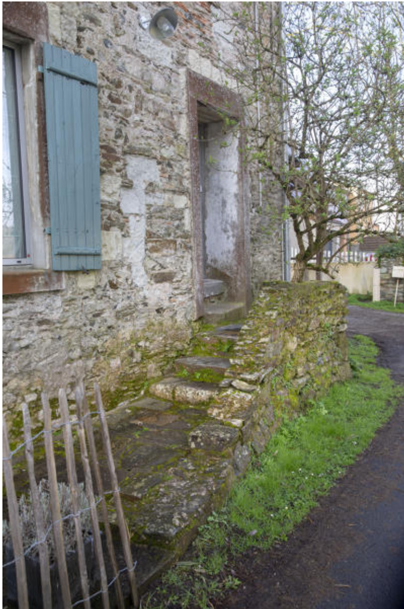
Maison, 40 bis rue des Pêcheurs. Détail de l'escalier extérieur.
