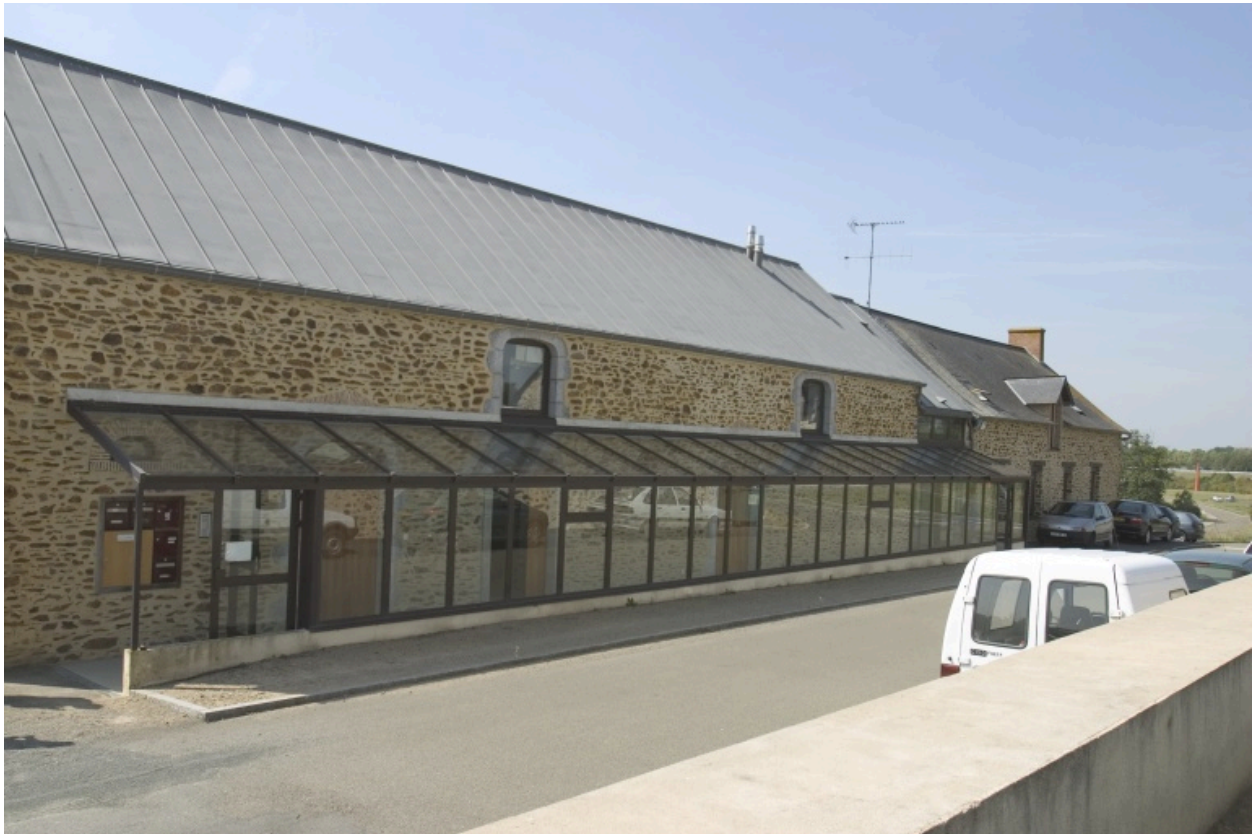
Le logis-étable vu depuis l'est.
