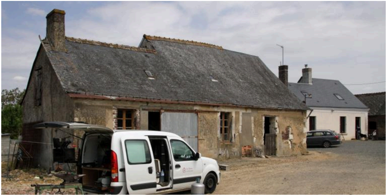
Maisons 2 et 3 : vue d'ensemble.
