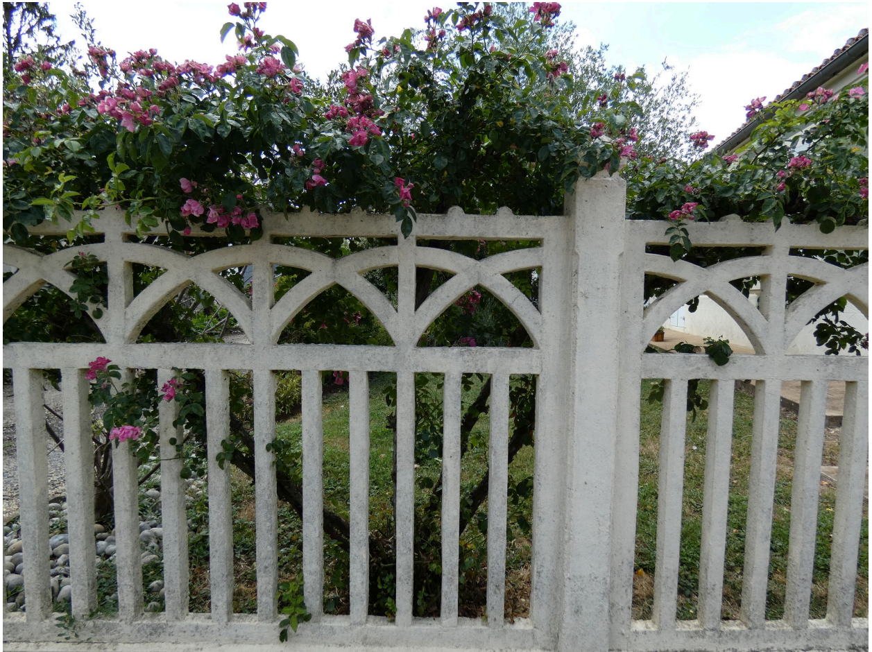
La clôture en ciment armé.
