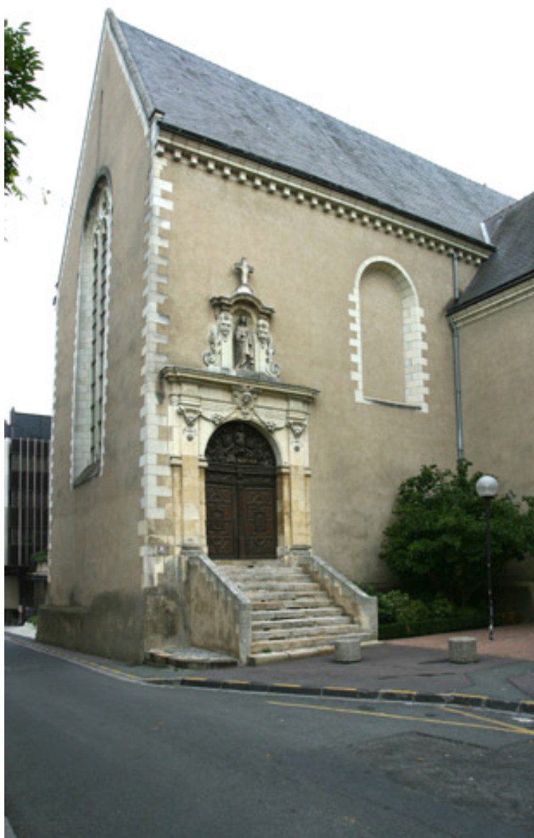
Eglise conventuelle : pignon ouest et élévation sud, avec le portail d'entrée.
