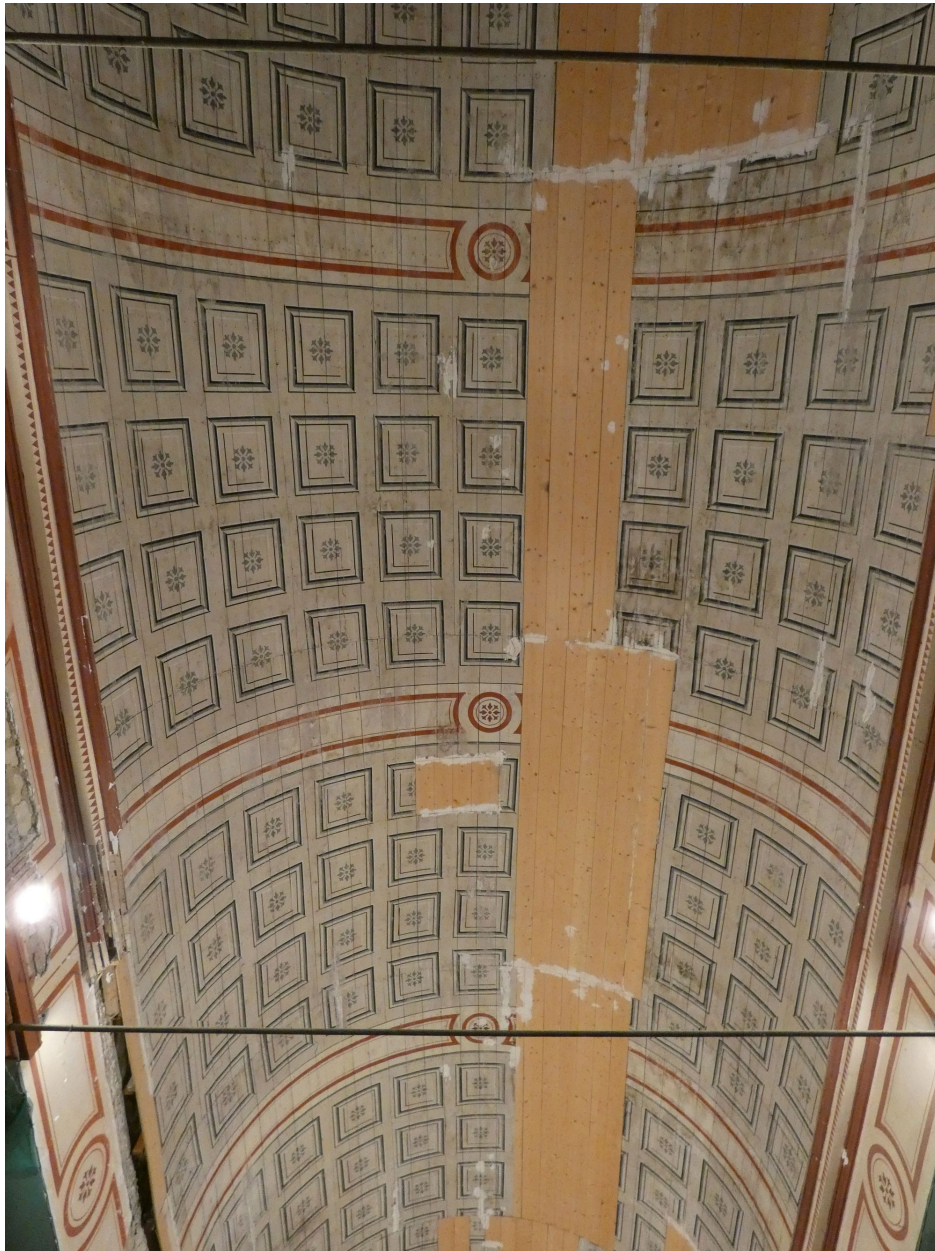
La fausse voûte en berceau de la nef.
