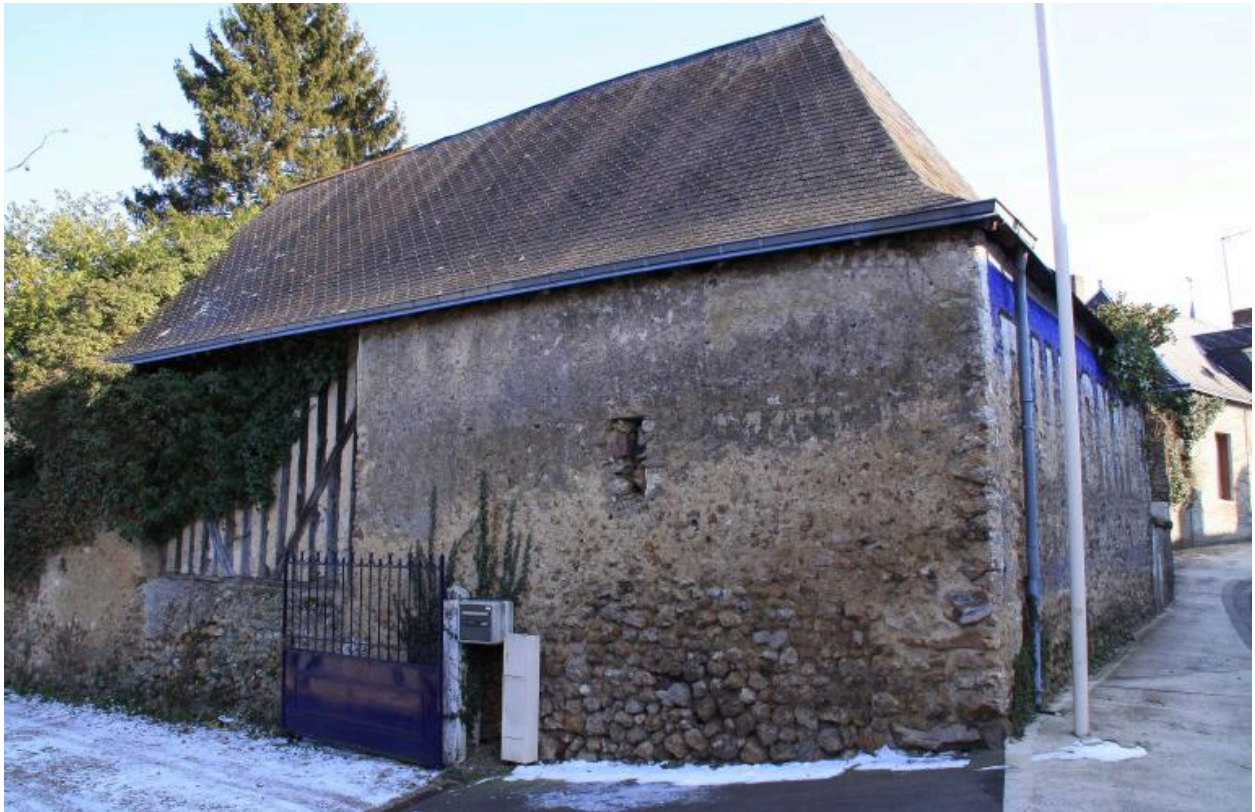
Grange, façade postérieure vue depuis la rue.
