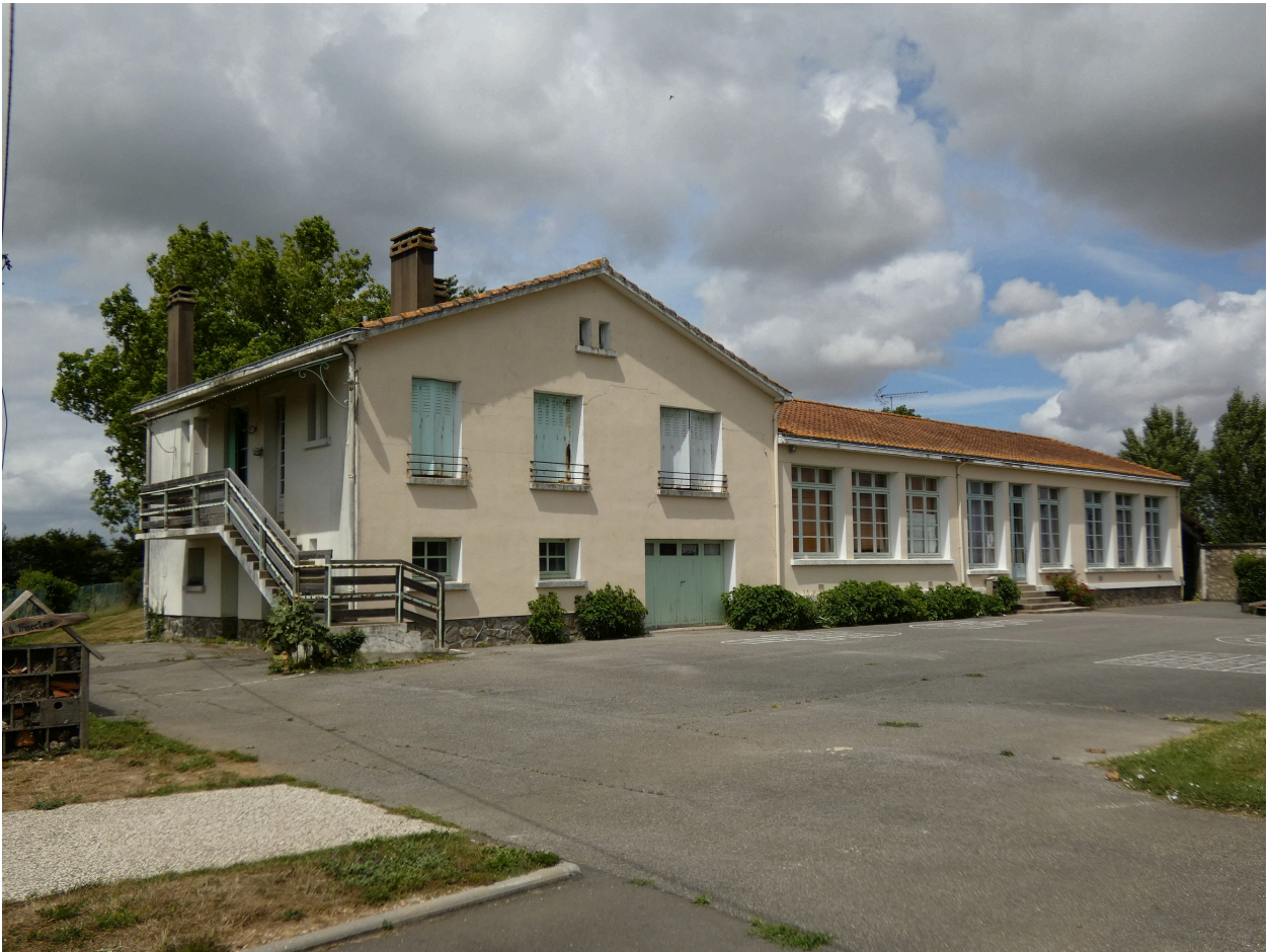
Le logement et le bâtiment de classes des années 1960, vus depuis le sud-ouest.
